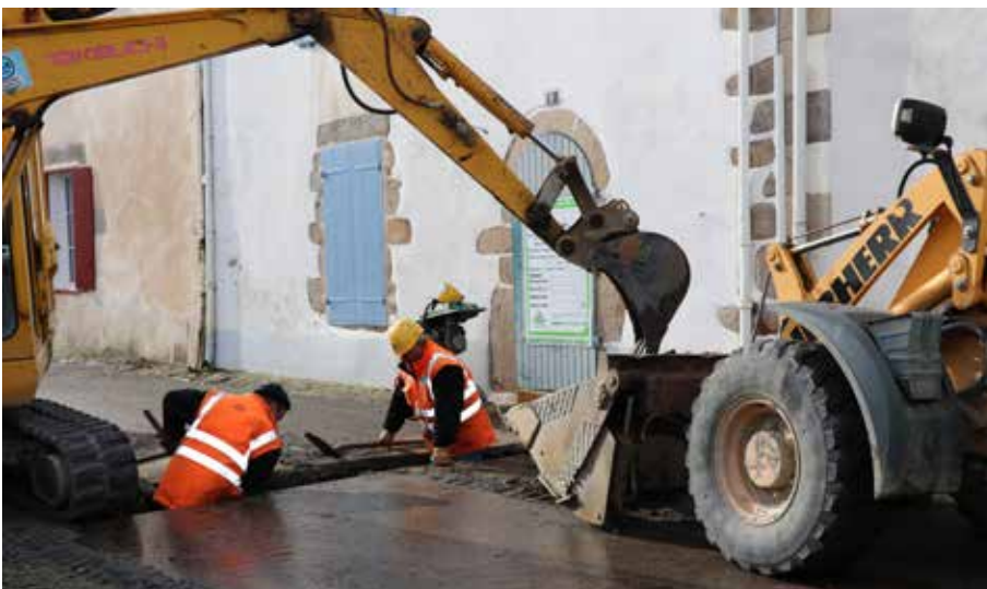
Renouvellement de l'adduction d'eau dans le quartier de la Ladure.
