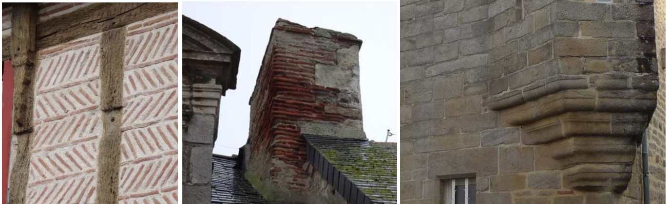
Structure en pan de bois avec remplissage en briques ; détail de souche de cheminée en briques (XVII e siècle) ; appareillage en pierre de taille
