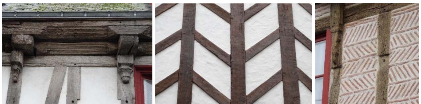
Détail de sablière et entretoise moulurées avec pigeâtres sculptés. Maison Guillaume André (vers 1558) détail des éléments disposés en fougère et numérotés pour en faciliter l'assemblage. Détail du remplissage en briques disposées en arêtes de poisson.
