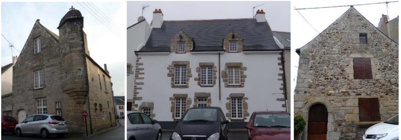
Maison noble de Kerermatz à pignon sur rue en pierre appareillée, 7 Grand Rue ; logis double (?) à façade sur mur gouttereau en moellons enduits, 7 place du Requier ; maison à rez-de-chaussée appareillé et mur de refend réalisée en maçonnerie.
