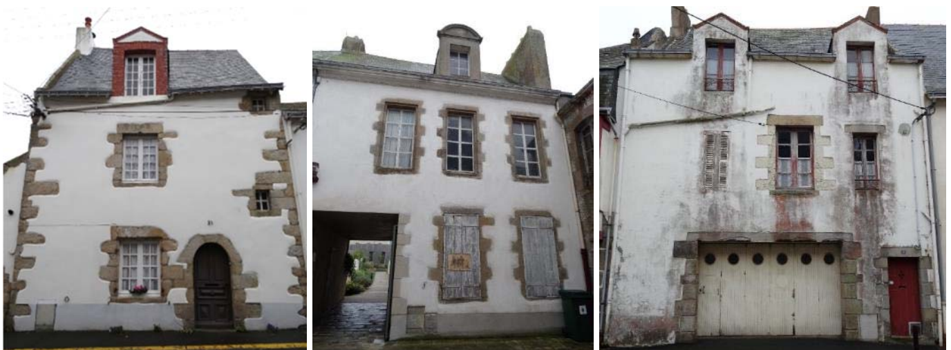
Maison à une travée avec entrée déportée (lucarne modifiée) avec petites baies de service éclairant la cage d'escalier situé en façade sur rue. Maison à trois travées à interaxe irrégulier mais à composition axiale. Maison lourdement modifiée (surélévation et frangement du rez-de-chaussée) portant la date de 1634 : cette construction présente à l'étage une composition ternaire typique des villes portuaires atlantiques (La Rochelle notamment) avec une travée centrale forte encadrée par deux baies très étroites.
