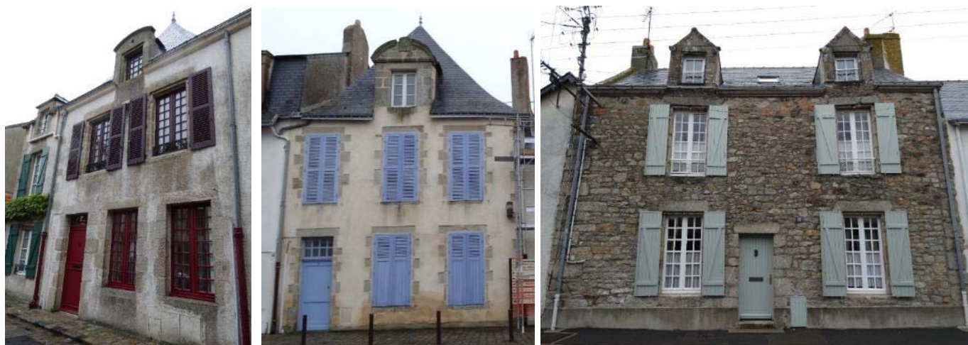
Maisons de ville à composition ternaire et axiale avec toiture en croupe ; maison à façade large rythmée par la répétition d'une travée avec lucarne à crossettes et boule de faitage.
