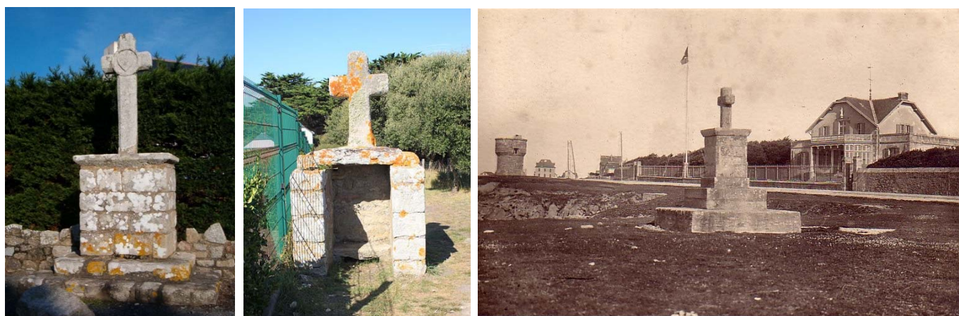
Les croix de Kervaudu, des Douaniers et « à ma fille », sur une carte postale ancienne, collection Laurent Delpire
