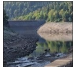
Les travaux terminés, le lac aval devrait être en eau en 2024. Photo DNA
