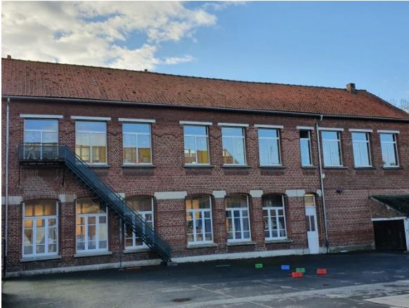
Le remplacement des châssis de l'école
