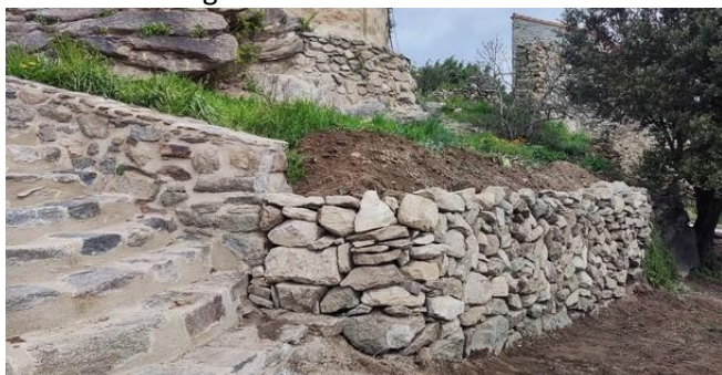
Nouveau mur de soutien des terres
