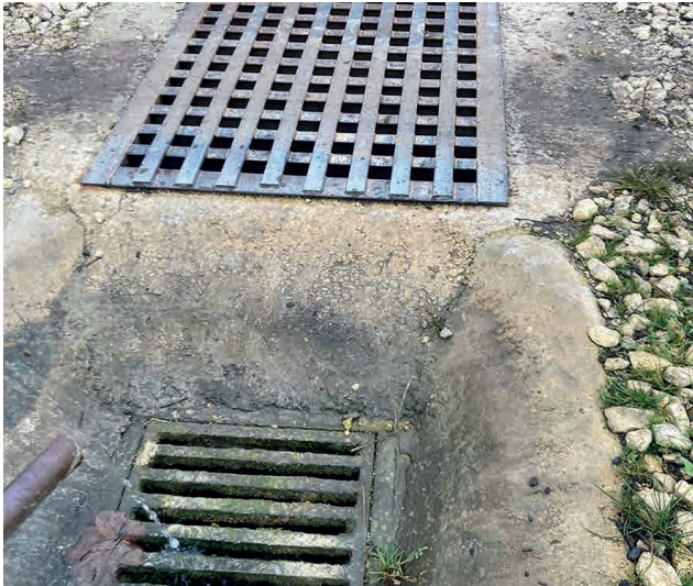
Hydraulique, captage de source, pose de grille
