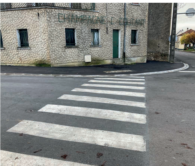
Réfection du trottoir rue de Tarbes
