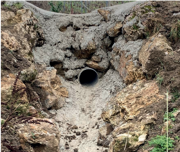
Renforcement et stabilisation du Chemin des Momignons
