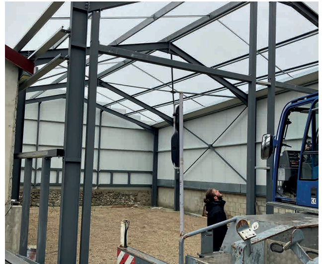
Construction d'une remise pour stockage de matériel
