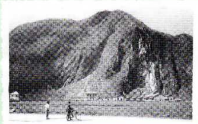
Usine hydroélectrique de la Corbière vers 1910 (vue de la plaine; hauteur de chute depuis la prise d'eau de Clarins: 725 m)
