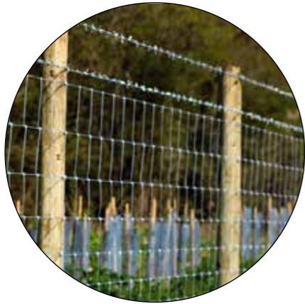
① Clôture rustique poteaux bois et grillage à maille carrée
