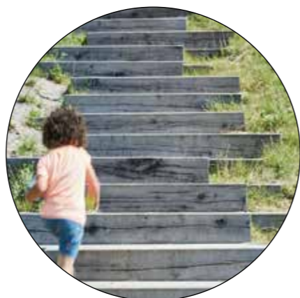
② Pas d'âne en bois à base de traverses bois et paliers engazonnés
