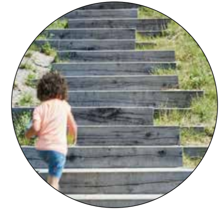
⑤ Escalier bois à base de traverses bois
