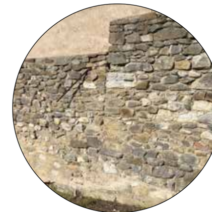
⑤ Appareillage de pierres issus de réemploi des pierres locales du mur et/ou de l'écurie
