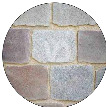
③ Pavés granit sciés issus de réemploi dim.18/22cm épaisseur 12/15cm
