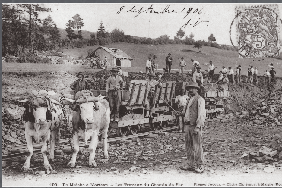
199. De Maïche à Morteau - Les Travaux du Chemin de Fer
