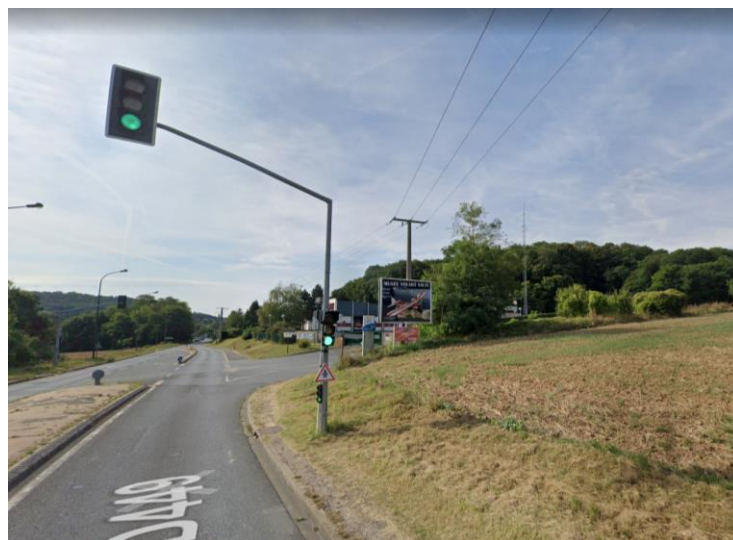
Vue rapprochée du carrefour à feux, depuis la RD449 (en venant du Nord)
