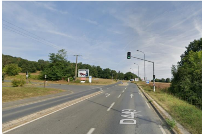
Vue rapprochée du carrefour à feux, depuis la RD449 (en venant du Sud)
