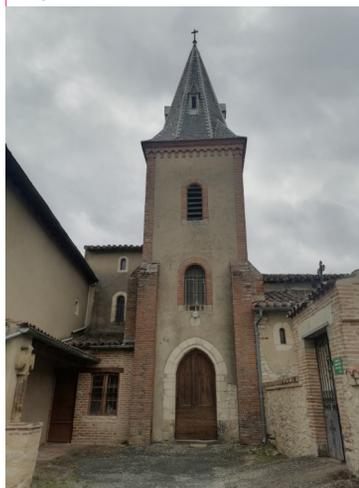
rejointoiement des parties pierres et briques. Des travaux de zinguerie seront aussi exécutés, le nettoyage et enlèvement de mousse sur la toiture.
