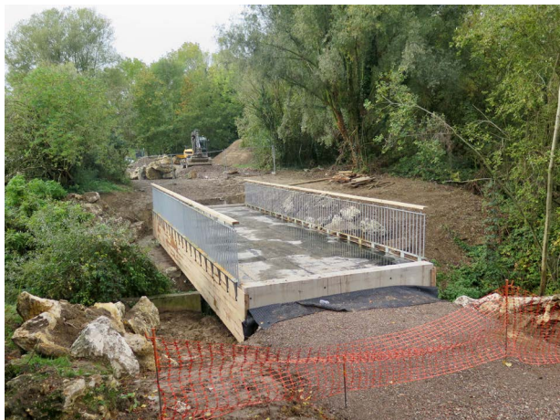
Le franchissement de la Gondoire, à la jonction entre Bussy-Saint-Georges et Chanteloup
