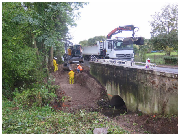
Le déploiement du réseau de chauffage urbain de Marne et Gondoire (alimenté par la chaleur des incinérateurs du Sietrem) le long de la D5 (ici, à Chanteloup) pour le connecter l'année prochaine à celui de Bussy-Saint-Georges, (pour le moment alimenté par une chaudière biomasse).
