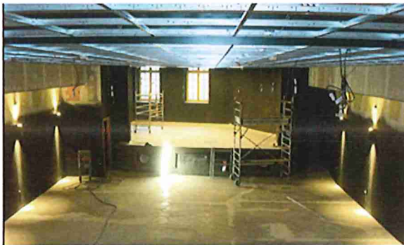
Vue générale de la salle
