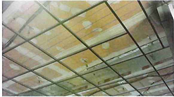
Plafond équipé de sa structure
