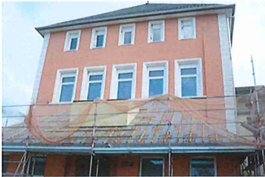
Façade repeinte avec appentis cinéma à finir
