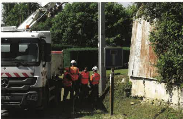
Déplacement d'un poteau béton rue des Brioux
