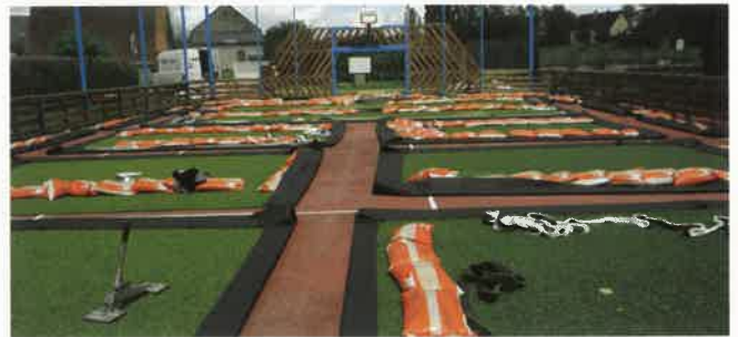
Pose nouveau gazon synthétique du City Stade
