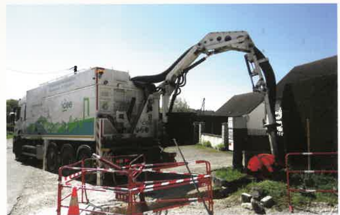
Terrassement par aspiration pour pose coffret de raccordement
