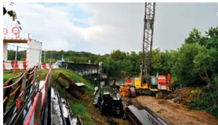
Des travaux pharaoniques, contraignants dans les mois à venir pour tous les usagers, mais le confort et la sécurité seront au final.
