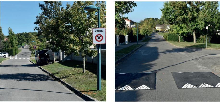
Abaissement en Zone 30 des deux lotissements. Le traçage d'un passage piéton a été réalisé avec la mise en place d'une chicane sur la voie à l'entrée du lotissement. Priorité est donnée aux véhicules montants. Deux jeux de coussins berlinois ont été mis en place aux angles de la rue des chanterelles, de l'impasse de la Jonchaie et de la rue de la roselière.
