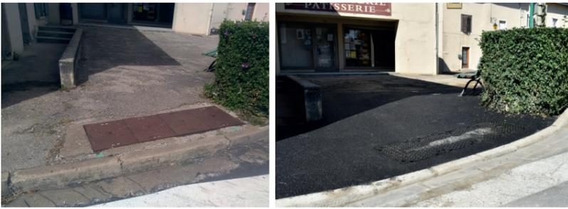
Depuis de nombreuses années cet accès posait véritablement des problèmes aux Varaxois(es). L'aménagement du passage PMR annoncé dans le bulletin trimestriel n°2 a enfin pu être réalisé. Il a nécessité l'abaissement de la chambre de tirage par une entreprise agréée Orange, des travaux de modification de la bordure de trottoir et une reprise partielle de l'enrobé devant la boulangerie par l'entreprise SOMEC.
