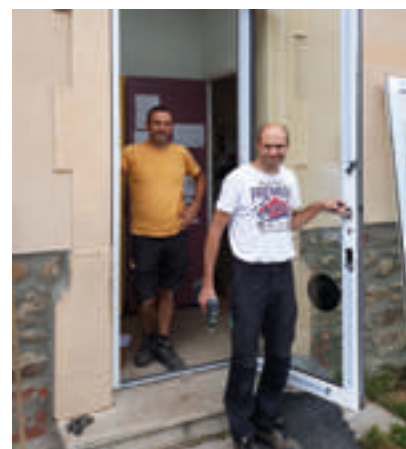
Tous les ouvrants ont été changés
