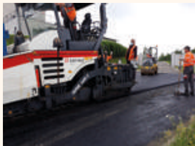
Pose du tapis d'enrobé à la zone artisanale
