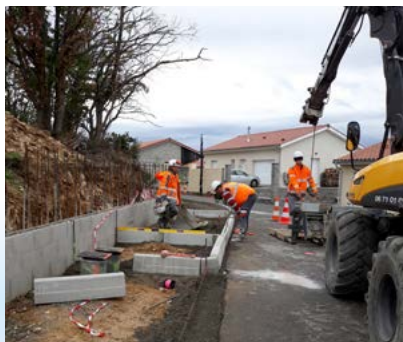
Pose trottoirs lotissement
