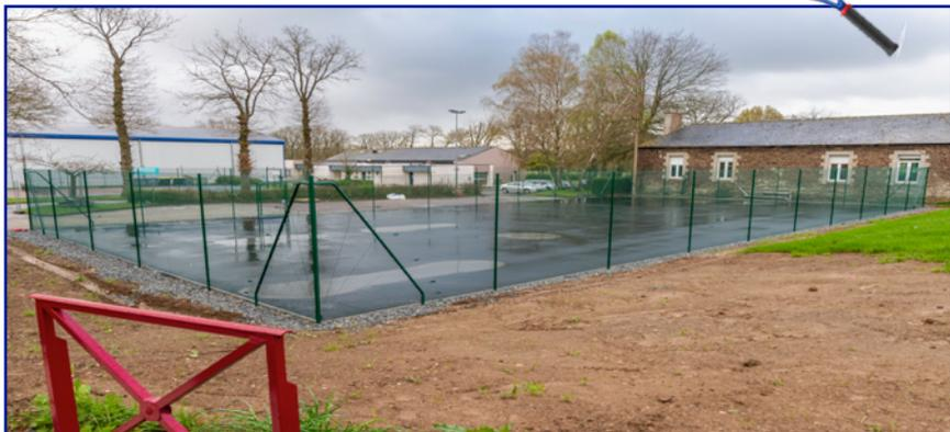
Les travaux du court de tennis extérieur ont commencé le 6 février dernier. L'entreprise Brocéliande TP a réalisé le terrassement, le drainage en périphérie du futur terrain, la mise en œuvre d'une couche de fondation, le compactage du sol et la mise en œuvre, en deux temps, d'un enrobé à chaud. Un contrôle de la planimétrie a été effectué par un laboratoire agréé.
