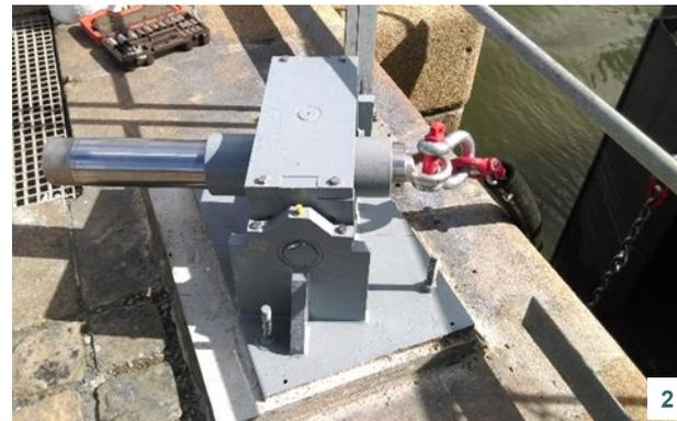
1 - Point d'ancrage des chaînes sur les vantaux
