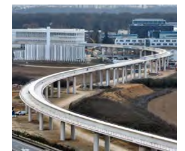
Le viaduc de la ligne 18 à Palaiseau
