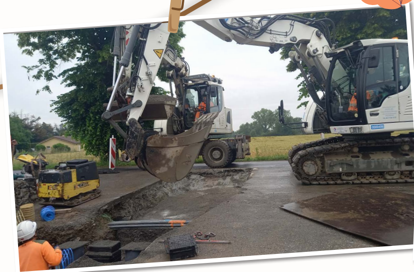
restructuration entrée Ouest
