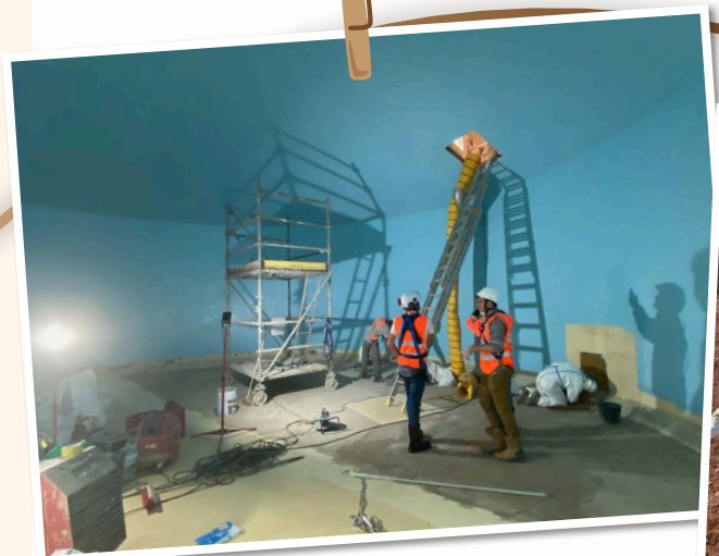
Réhabilitation réservoir val d'Anzieux
