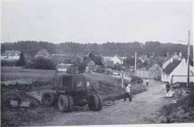
TRAVAUX RUE DE BEAUCE
