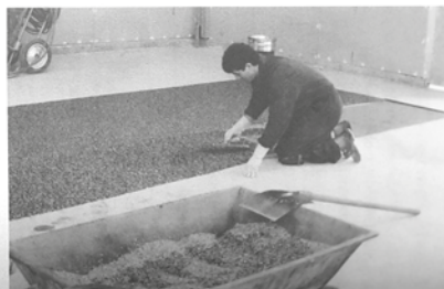
La mise en place du revêtement du sol sportif.
