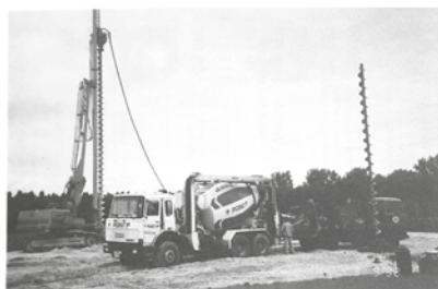
Le Gymnase : le forage des pieux.
