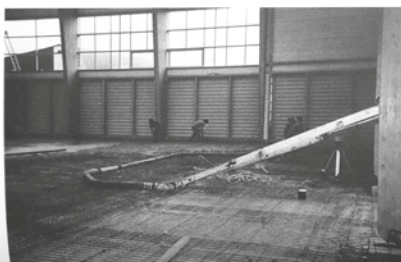
La réalisation de la dalle portée sur les pieux.
