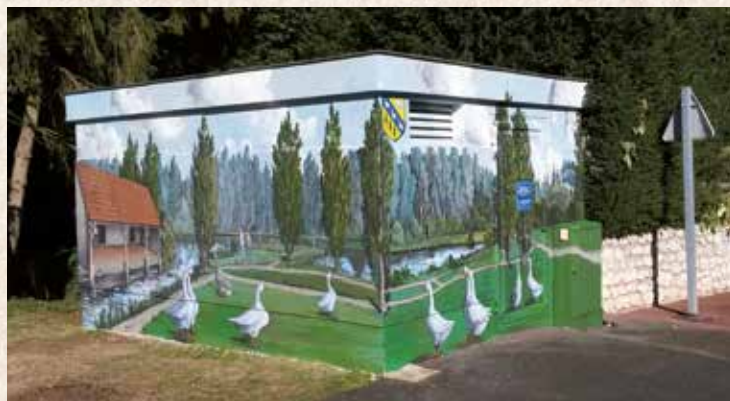
Transformateur du Bois de l'Abbaye peint en 2016
