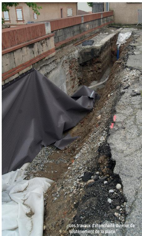
Les travaux d'étanchéité du mur de soutènement de la place.
