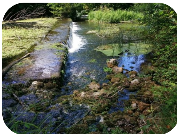
Brèche à aménager au barrage de Commenjard (Clain 20)
