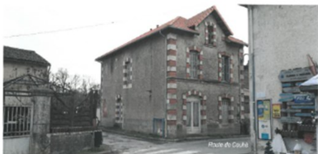
Vue suivant DP 7
