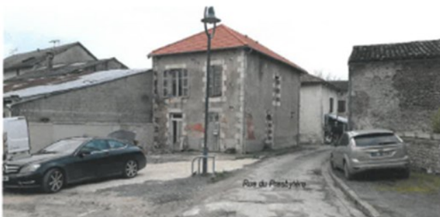
Vue suivant DP 8-2
