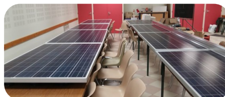
Panneaux photovoltaïques en préparation
