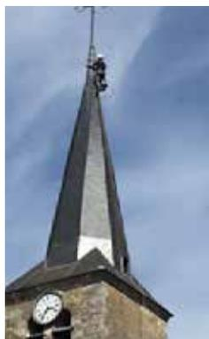
En effet, l'isolement électrique et l'état des conducteurs de descente n'étaient plus conformes. Par ailleurs, la pointe radioactive des anciens équipements n'est plus autorisée.
