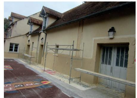
R fection compl te de la couverture des deux pr aux   l' cole  l mentaire : la consolidation de la charpente et le remplacement des tuiles  taient devenus n cessaires vu l' tat d grad  des mat riaux et la pr sence d'amiante dans les ardoises. ▼
