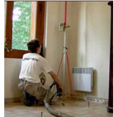
Relevage et contrôle
