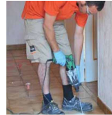
perçement des trous
