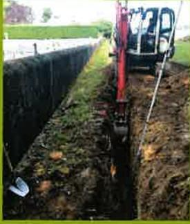
Des travaux de drainage ont donc été entrepris en amont et sur le côté droit du cimetière pour se raccorder au pluvial de chaussée à l'aval de l'abri bus. Sur la partie Nord, le drain posé a été creusé sur une hauteur de 2.5 m afin d'être au niveau bas des tombes situées en aval.
