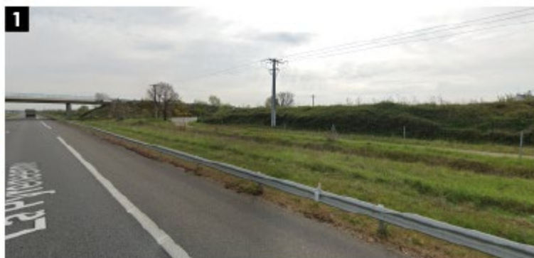
1 Avant le pont de la RD10g
