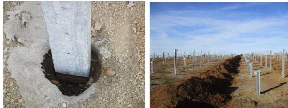
Illustration 6 : Exemple de fondation type pieux – RES
