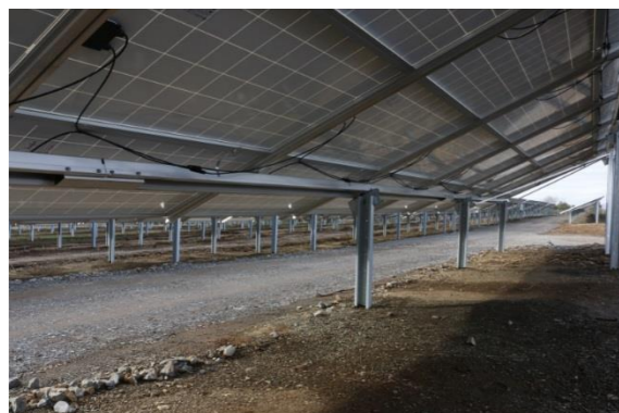
Illustration 18 : Exemple de pistes empierrées – RES
