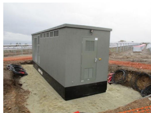
Installation d'un poste électrique - RES
