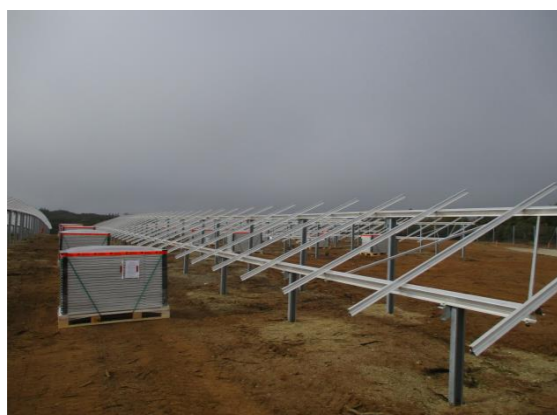
Assemblage des structures sur site – RES
