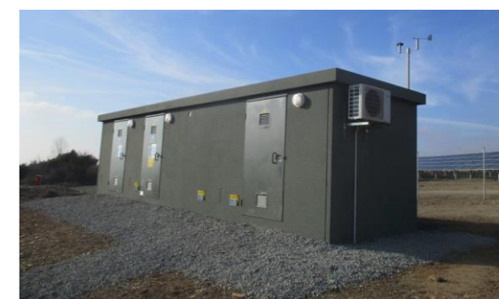
Illustration 16 : Exemple de structure de livraison - RES
