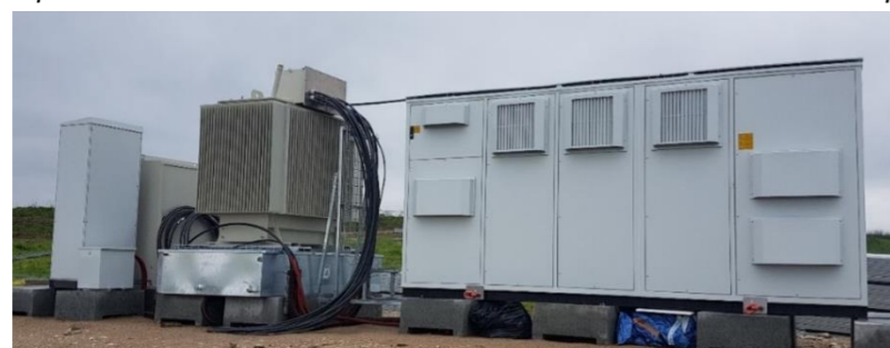
Illustration 14 : Exemples d'onduleurs installés à l'extérieur et transformateur dans un poste béton
