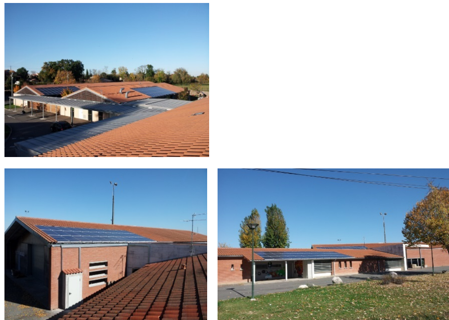
Figure 4 : installations des panneaux photovoltaïques réalisées sur les bâtiments communaux, source : commune de Lafitte-Vigordane
