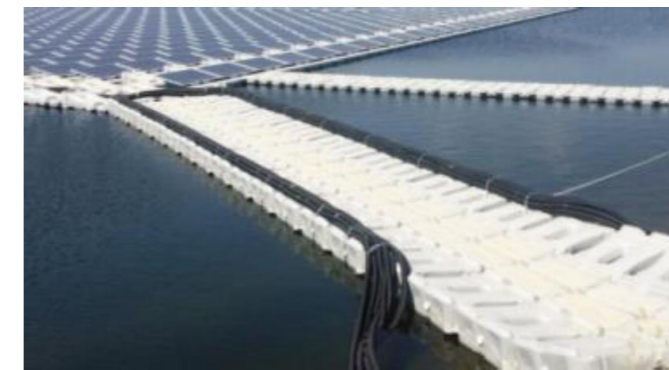
Exemples d'acheminement des câbles (source Ciel&Terre)
