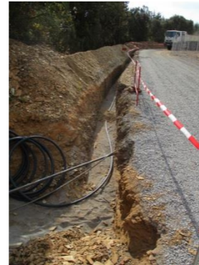
Exemple de tranchée en bordure de piste – RES
