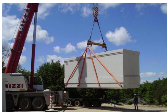
Installation d'un poste électrique - RES
