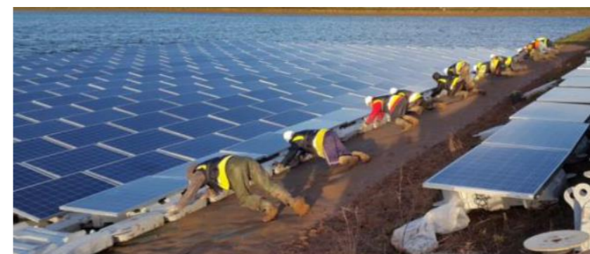
Mise à l'eau de flotteurs (source Ciel&Terre)
