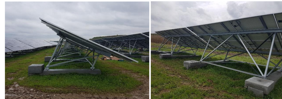
Illustration 8 : Exemple de fondations béton - RES
