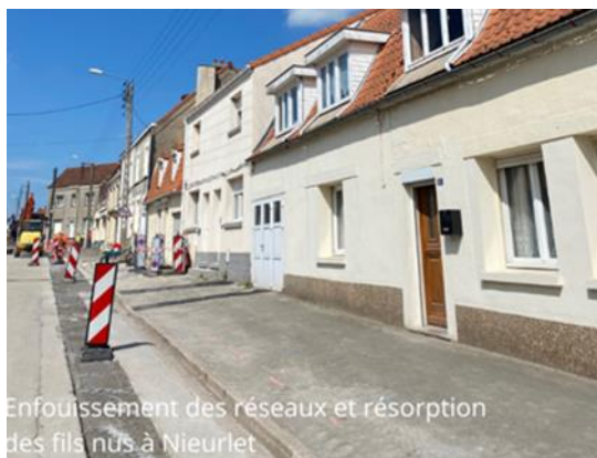
Chantier Article 8 avec résorption de fils nus à NIEURLET
