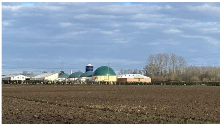
Mise en gaz de l'unité de méthanisation LIEVIN à Volckerinckhove Février 2021
