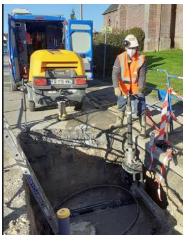
Mise en gaz à NIEURLET NOV 2020
