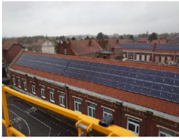
Photovoltaïque en Toiture
