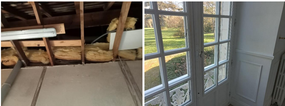
Photo de l'isolation en combles R+2 et des menuiseries façade Nord
