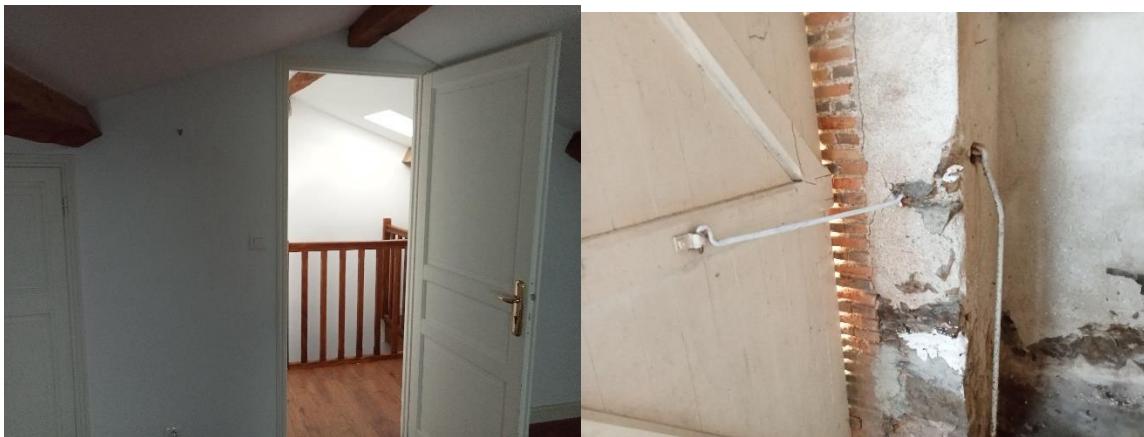
Partie habitée de la dépendance à gauche et mur non isolé partie non chauffée à droite
