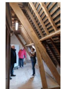
échappée sous charpente
