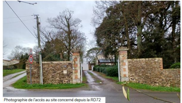
Photographie de l'accès au site concerné depuis la RD72
