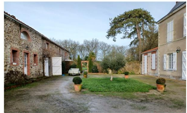
La cour et le face à face entre les 2 écritures architecturales : la maison de maitre et la dépendance rurale
