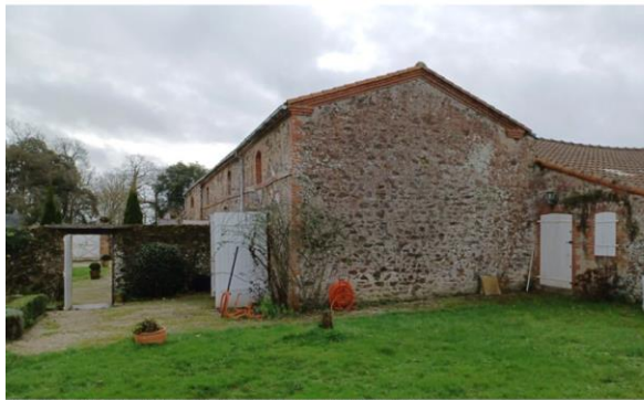
L'accès nord à la cour et la connexion à la partie piscine de plein air
