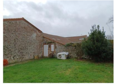
vue sur le pignon nord des dependance face à la piscine
