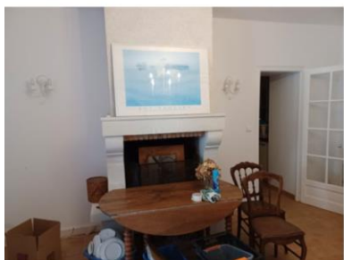
détail sur cheminée de la partie rénovée
