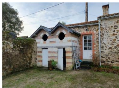
détail architectural sur le patrimoine de dépendance
