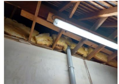
détail sous rampant et vestige isolant
