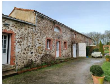
la facade est de la partie rénovée de la dépendance
