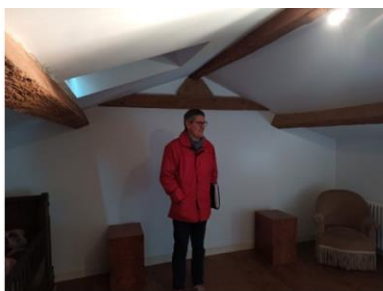
détail des combles de la partie rénovée sous rampant
