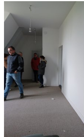
comble 2eme etage
