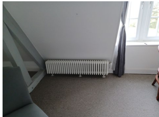
détail sous rampant et parti rénovée
