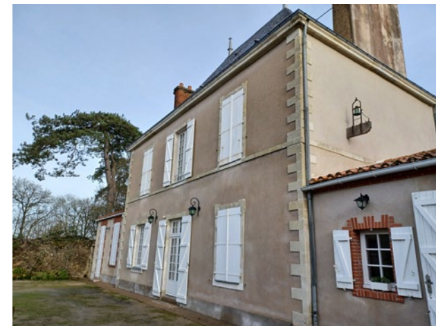
la facade ouest de la maison de maitre
