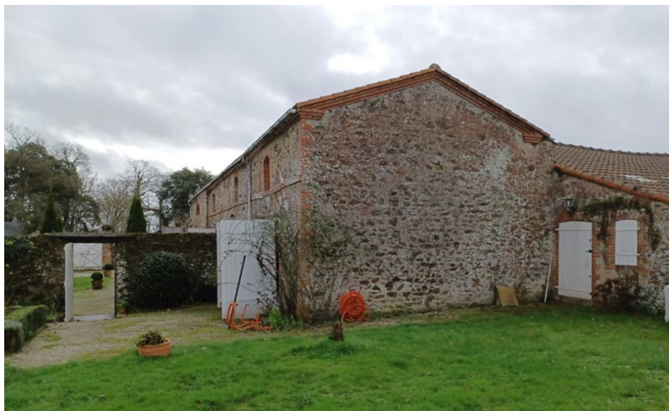
L'accès nord à la cour et la connexion a la partie piscine de plein air
