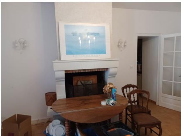
détail sur cheminée de la partie rénovée
