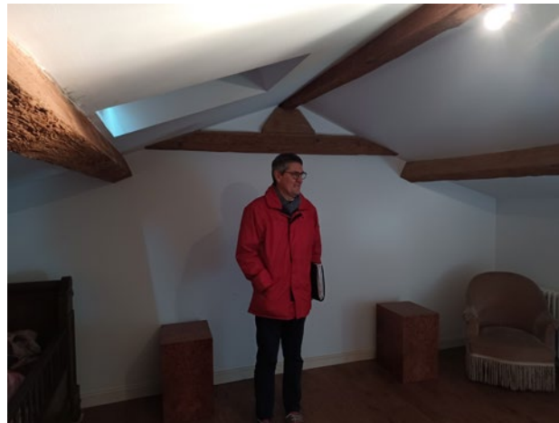
détail des combles de la partie rénovée sous rampant
