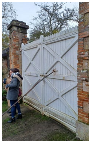
le portail d'accès depuis la RD72
