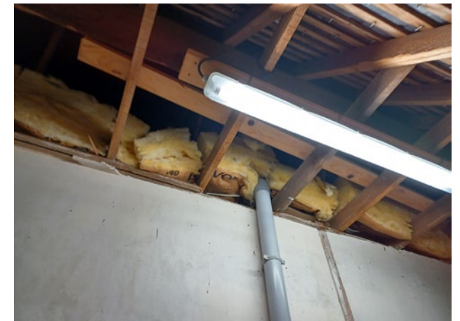
détail sous rampant et vestige isolant
