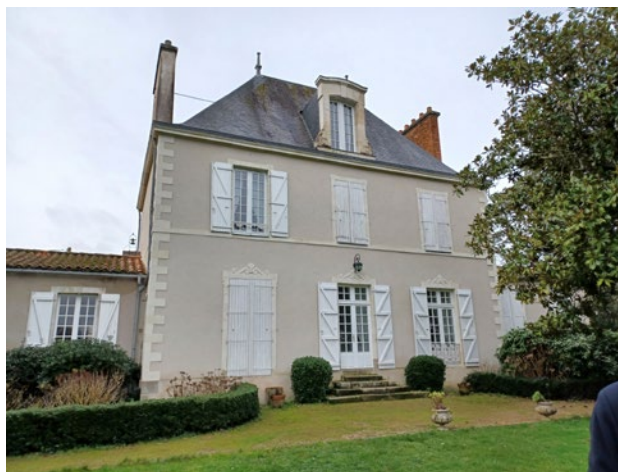
vue sur la facade arriere et son emmarchement
