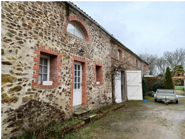
détail de la façades et des percements singuliers
