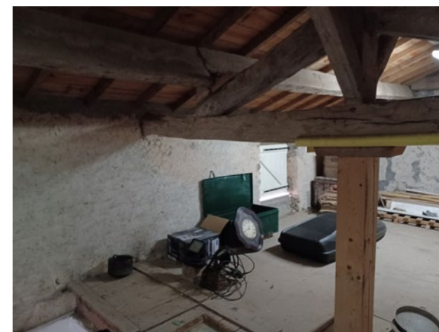
mezzanine accessible au dessus de la cave
