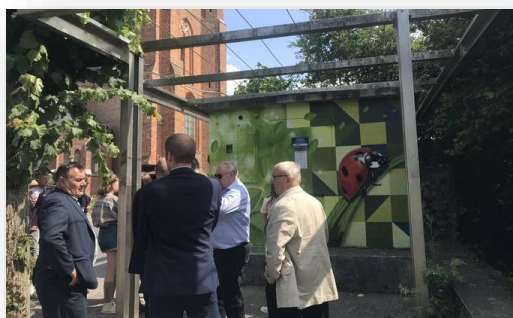
RELOOKAGE DU POSTE HTA/BT A SAINT-JANS-CAPPEL – JUILLET 2019
