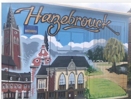
RELOOKAGE DU POSTE HTA/BT A HAZEBROUCK – JUILLET 2019
