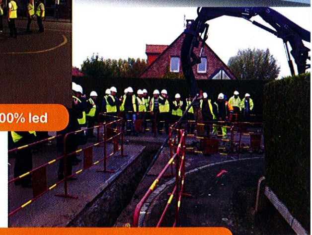
visite d'un chantier GrDF à Hoyville
