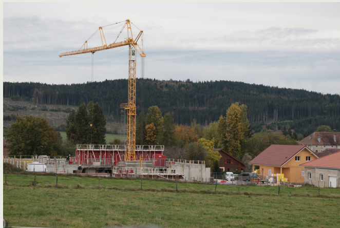
Les travaux de la résidence senior
