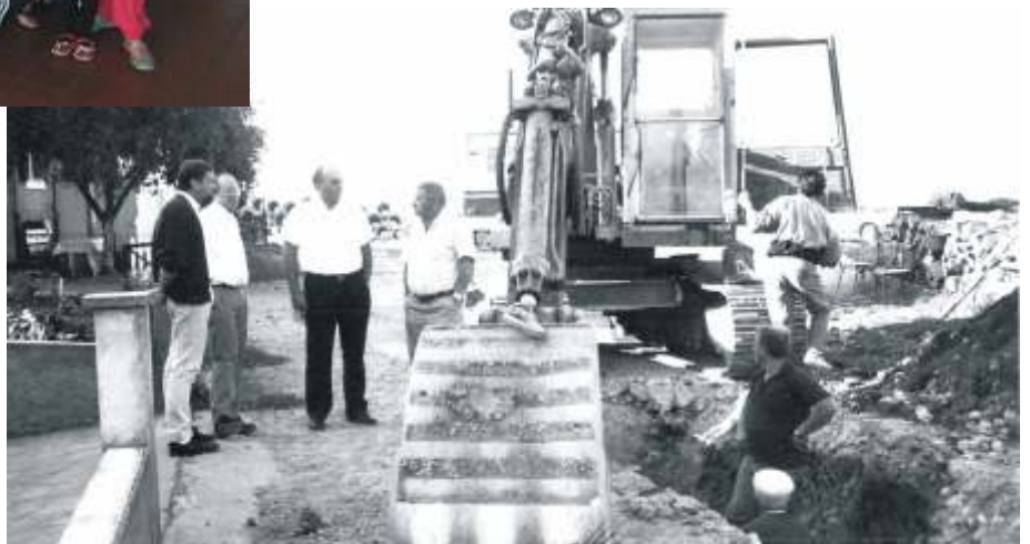
Travaux rue du Puits
