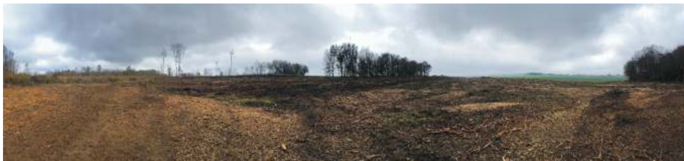
Vue de la parcelle 6 en cours de broyage
