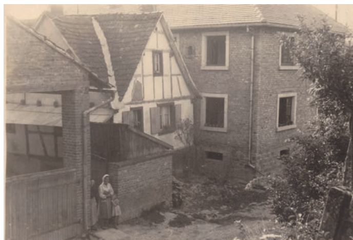
L'ancienne ferme « s'Schwitzers », à droite la nouvelle maison en construction.
