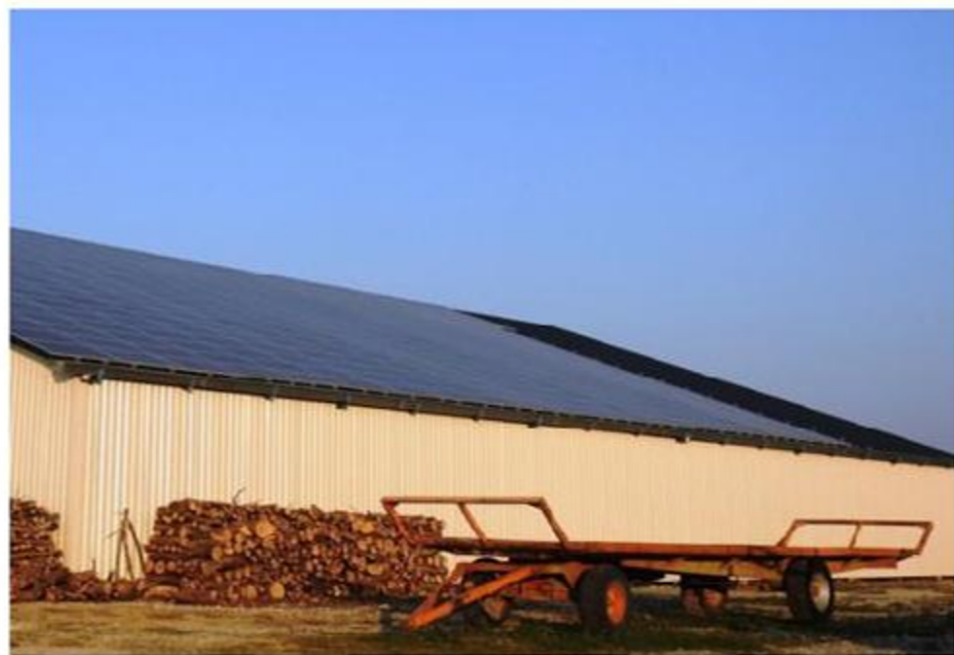
Les énergies renouvelables sont déjà utilisées par des agriculteurs de la commune avec notamment, des toits photovoltaïques sur des bâtiments agricoles. (Photo NR)
