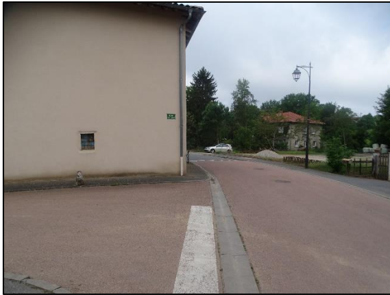
Intersection avec manque de visibilité entre le chemin de Vignol et la route du Morbier
