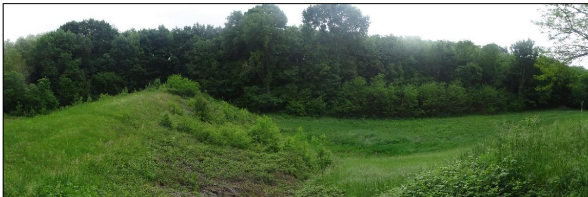
Ouvrage de rétention sur le ruisseau du Vignol (digue)
