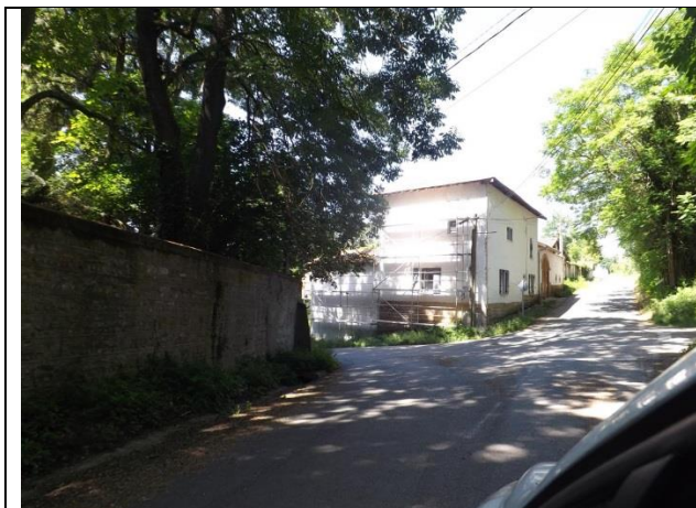
Ravalement de façade sur un bâtiment en pisé En Broussailles
