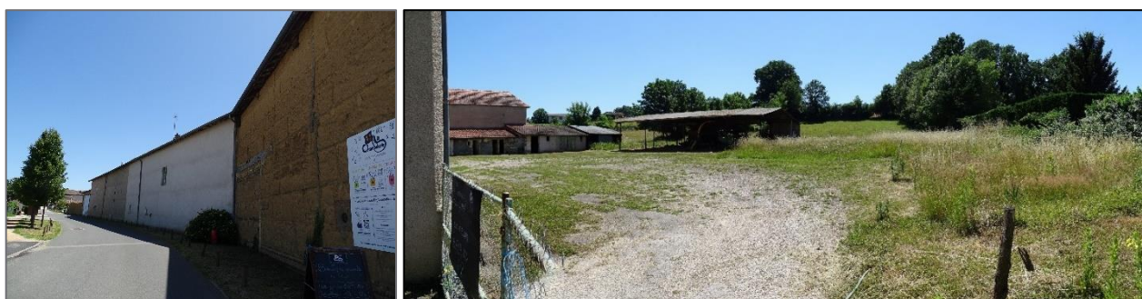
Site des anciennes fermes implanté le long de la route du Morbier
