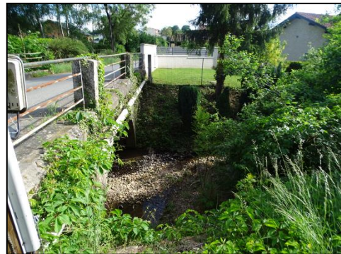
Passage du Morbier sous le chemin de Fourvière
