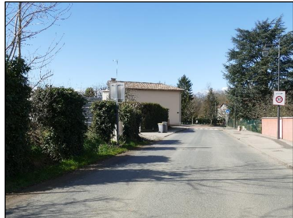
Début de la "Zone 30" en entrée Est du bourg
