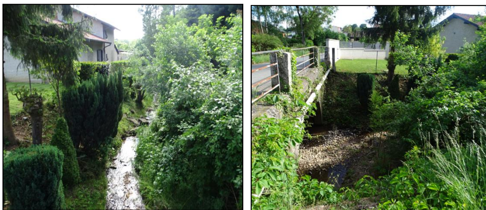
Traversée du ruisseau Morbier au sein des secteurs urbanisés de Toussieux
