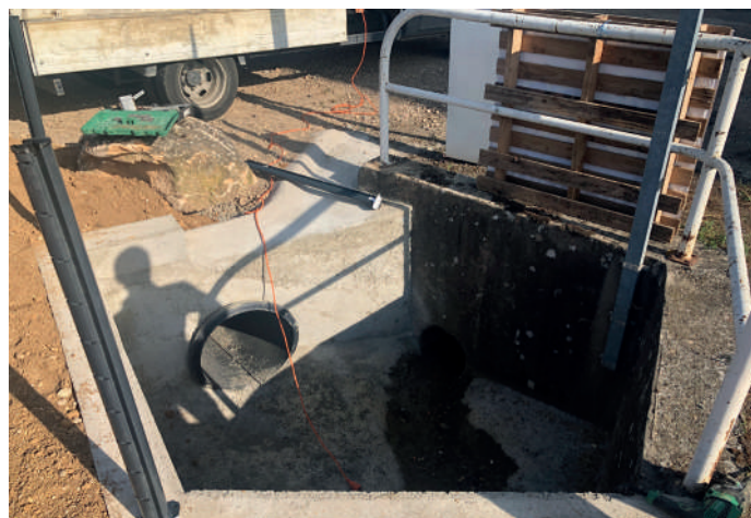
Reprise du collecteur eaux pluviales
