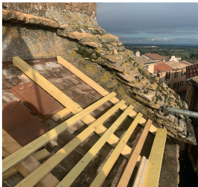
Réfection du toit des bas-côtés de l'église
