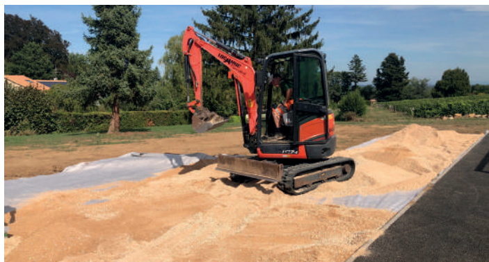
Aménagement des abords des terrains de sports
