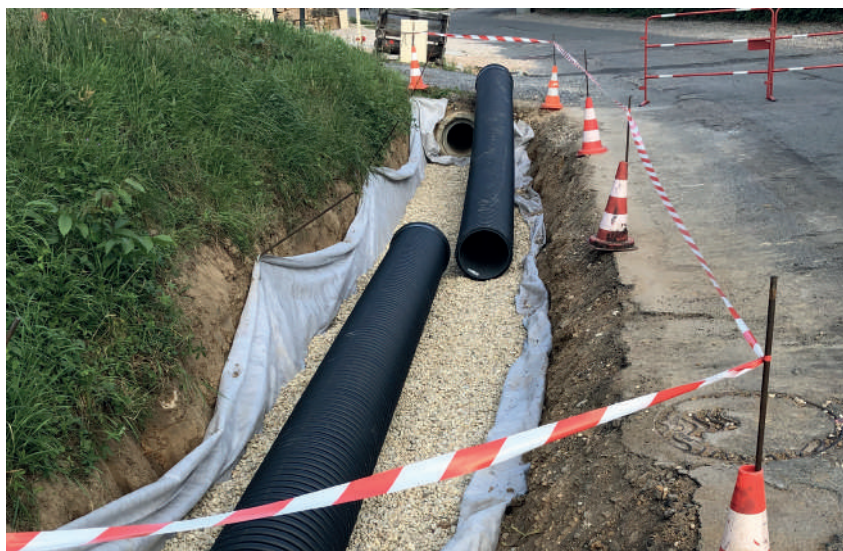
Busage des fossés rue de Malpertuis
