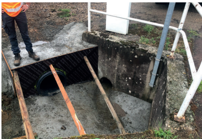
Reprise du collecteur eaux pluviales
