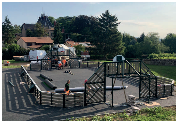
Construction d'un terrain multisport
