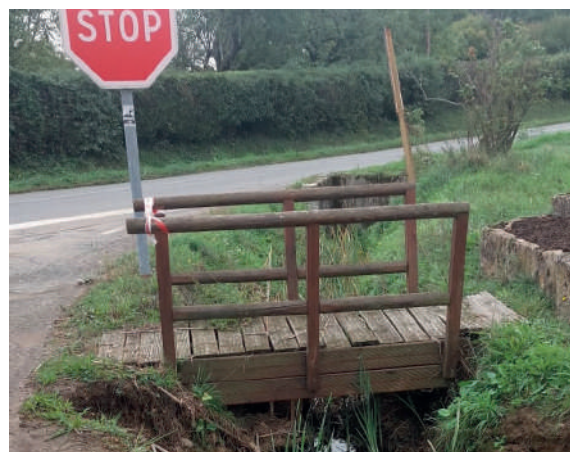
Reconstruction du petit pont (rue des sources)
