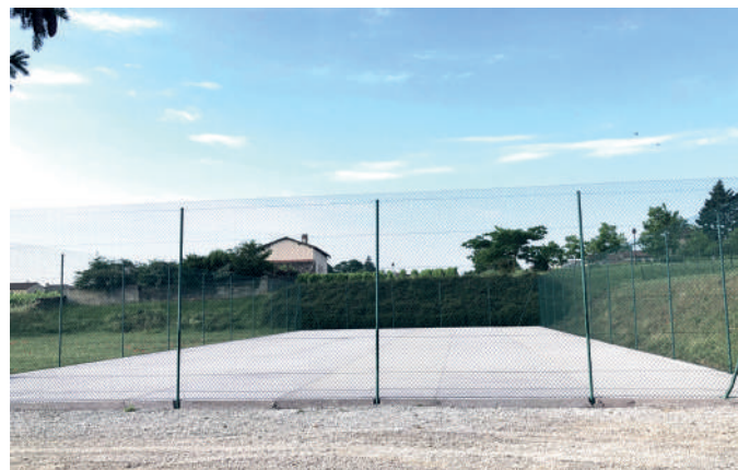
Réfection du terrain de tennis
