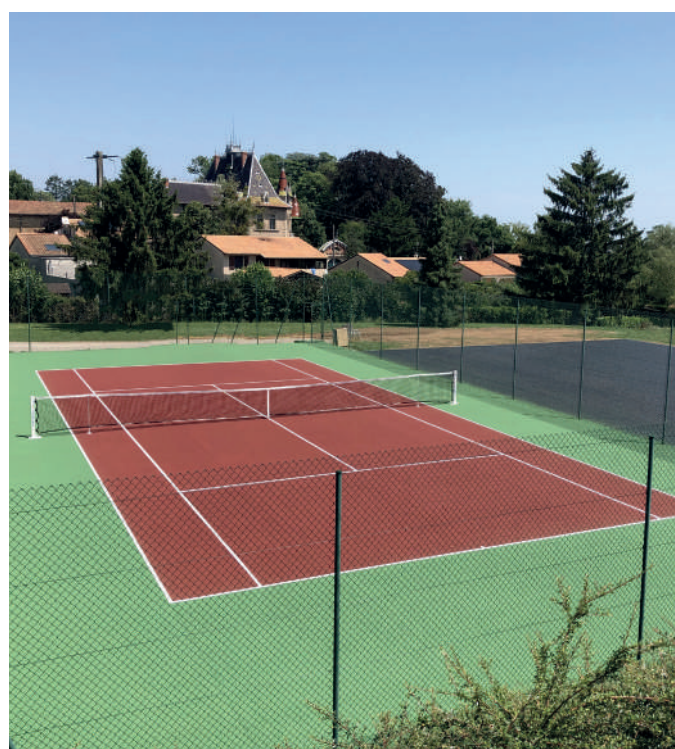
Réfection du terrain de tennis
