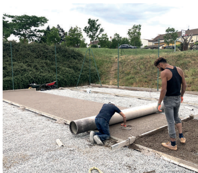
Réfection du terrain de tennis
