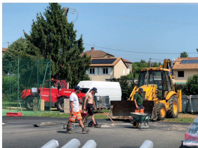
Construction d'un terrain multisport
