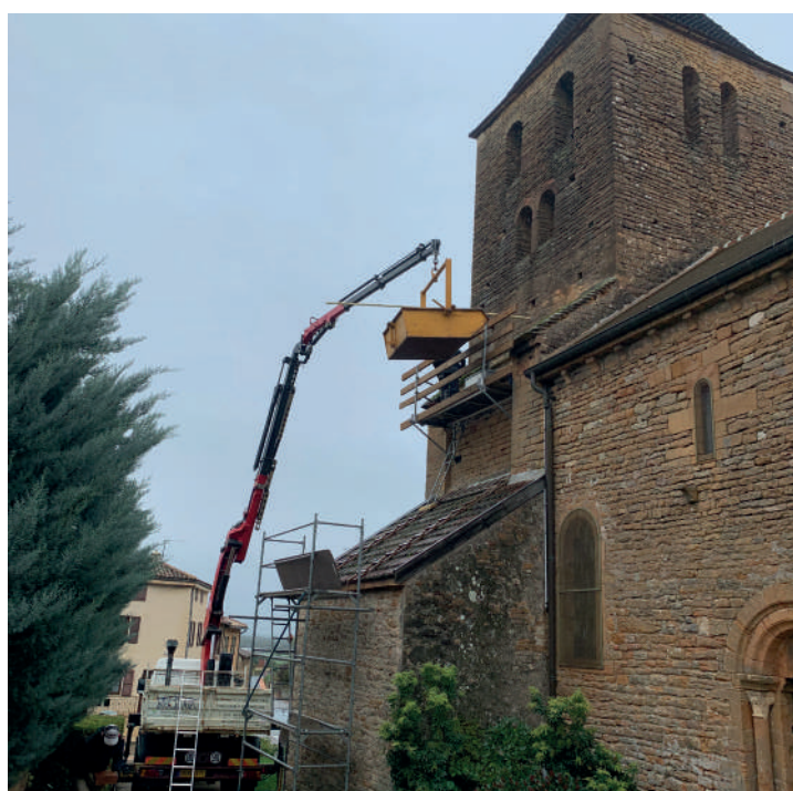
Réfection du toit des bas-côtés de l'église
