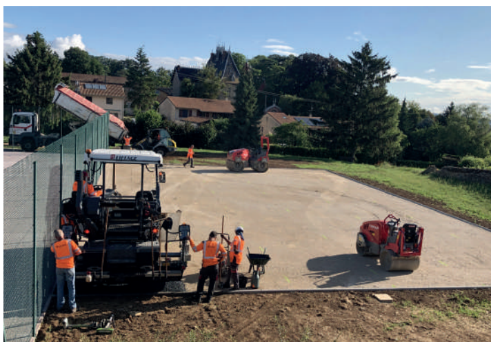
Construction d'un terrain multisport
