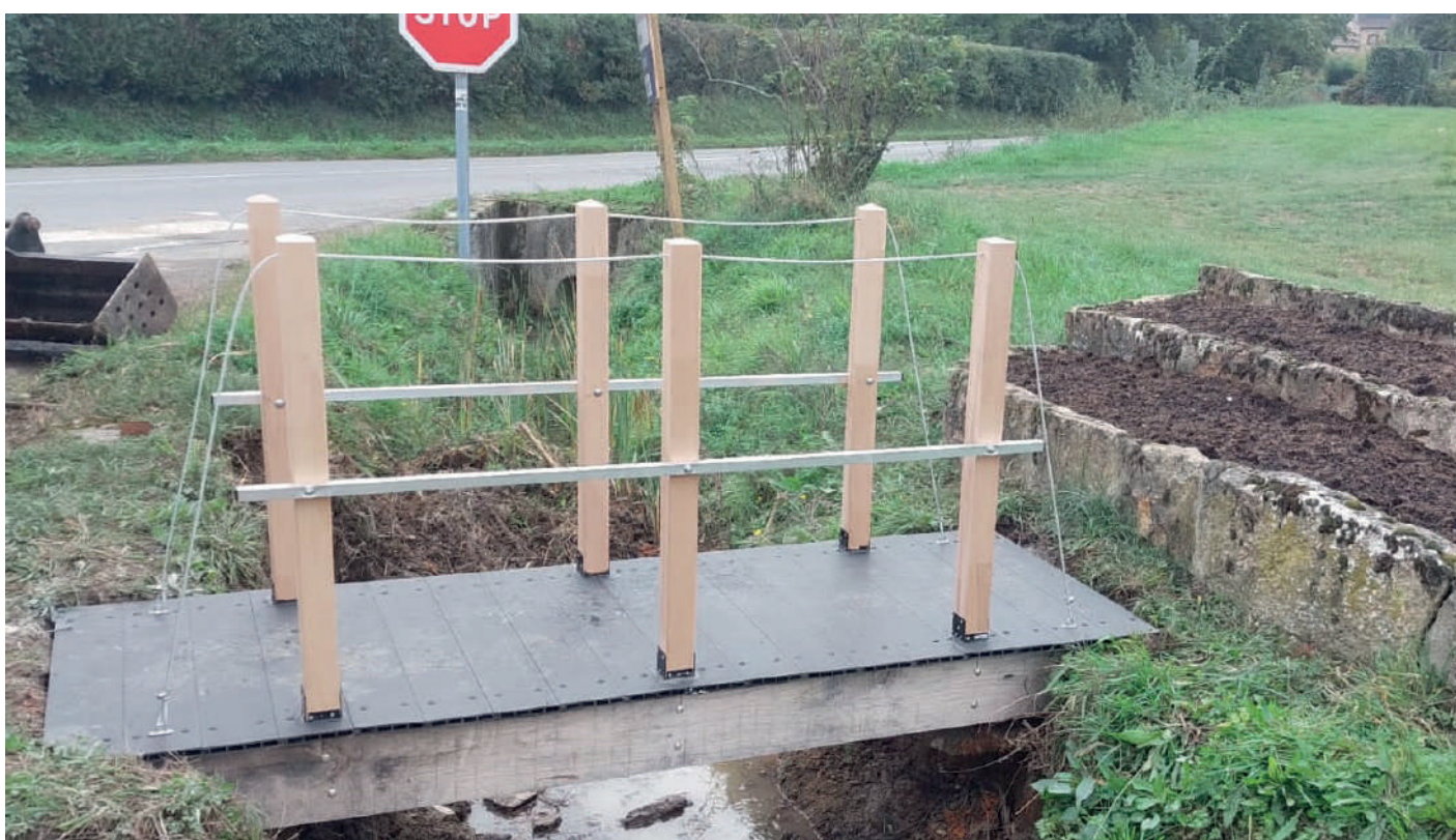
Reconstruction du petit pont (rue des sources)
