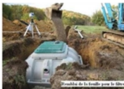
Photos : Autres exemple d'installation d'ANC avant et après remblai
