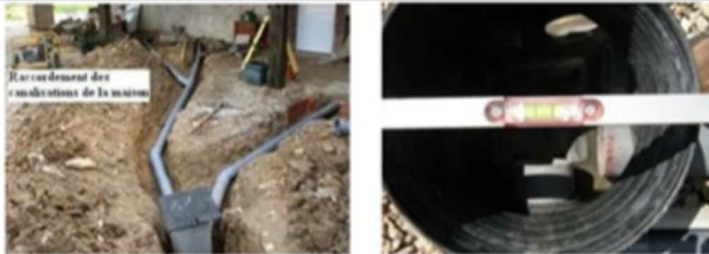
Photos : Vérification de la collecte des effluents et mesure de l'horizontalité sur un regard de visite
