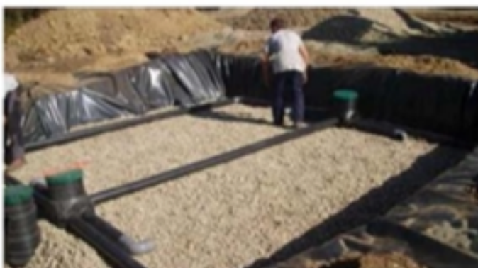
Photos: Situation de l'installation d'assainissement non collectif avant le contrôle de bonne réalisation.
