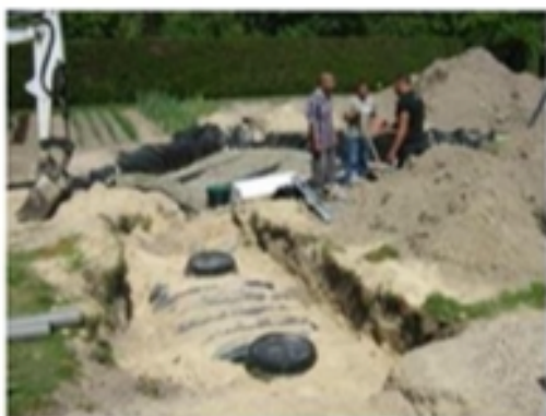
Photos: Situation de l'installation d'assainissement non collectif avant le contrôle de bonne réalisation.
