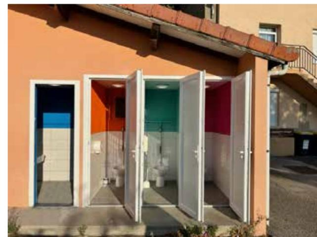
Les toilettes de la cour ont bénéficié de l'arrivée d'un sol carrelé, de la création de plafonds suspendus et l'installation d'éclairage LED à détection de présence.
