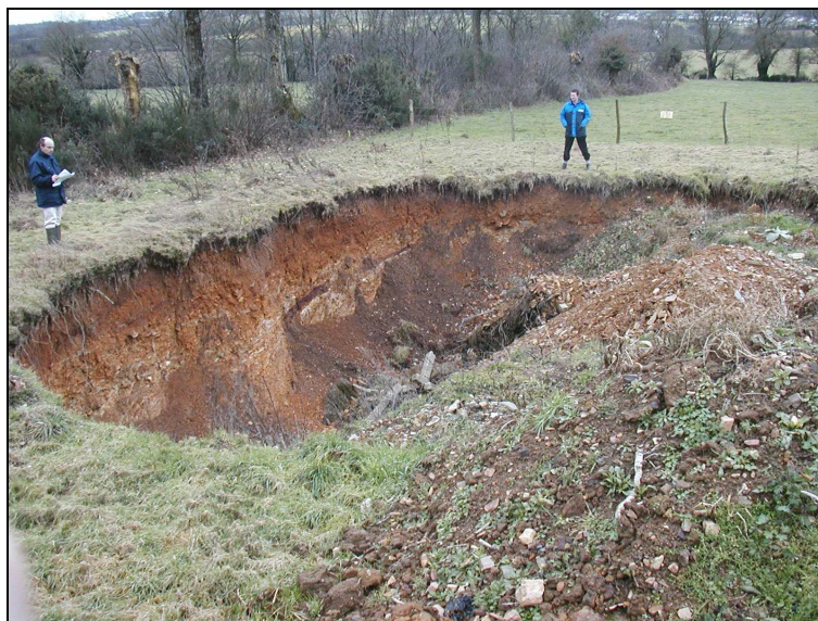
Effondrement localisé de grande dimension
