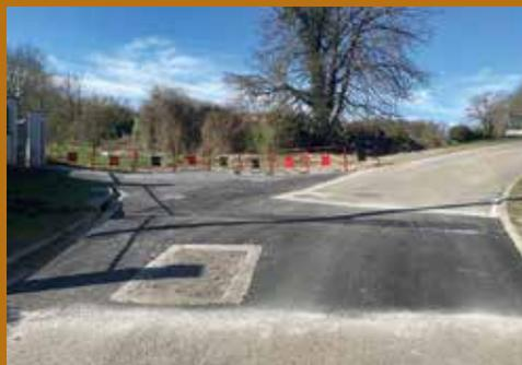
La **rue de la Longue Haie** : mise en place d'un avaloir et réfection d'une partie de la route avec rehaussement des trottoirs.
